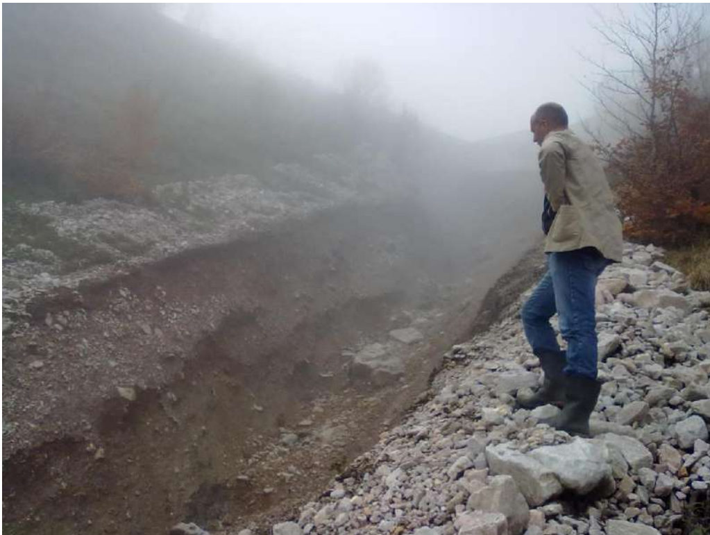
Foto 27: Erozioni te Reka e Kafexhisë
