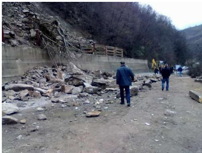
Foto 20 : Shembja e dheut dhe Gurëve në rrugën Magjistrale
