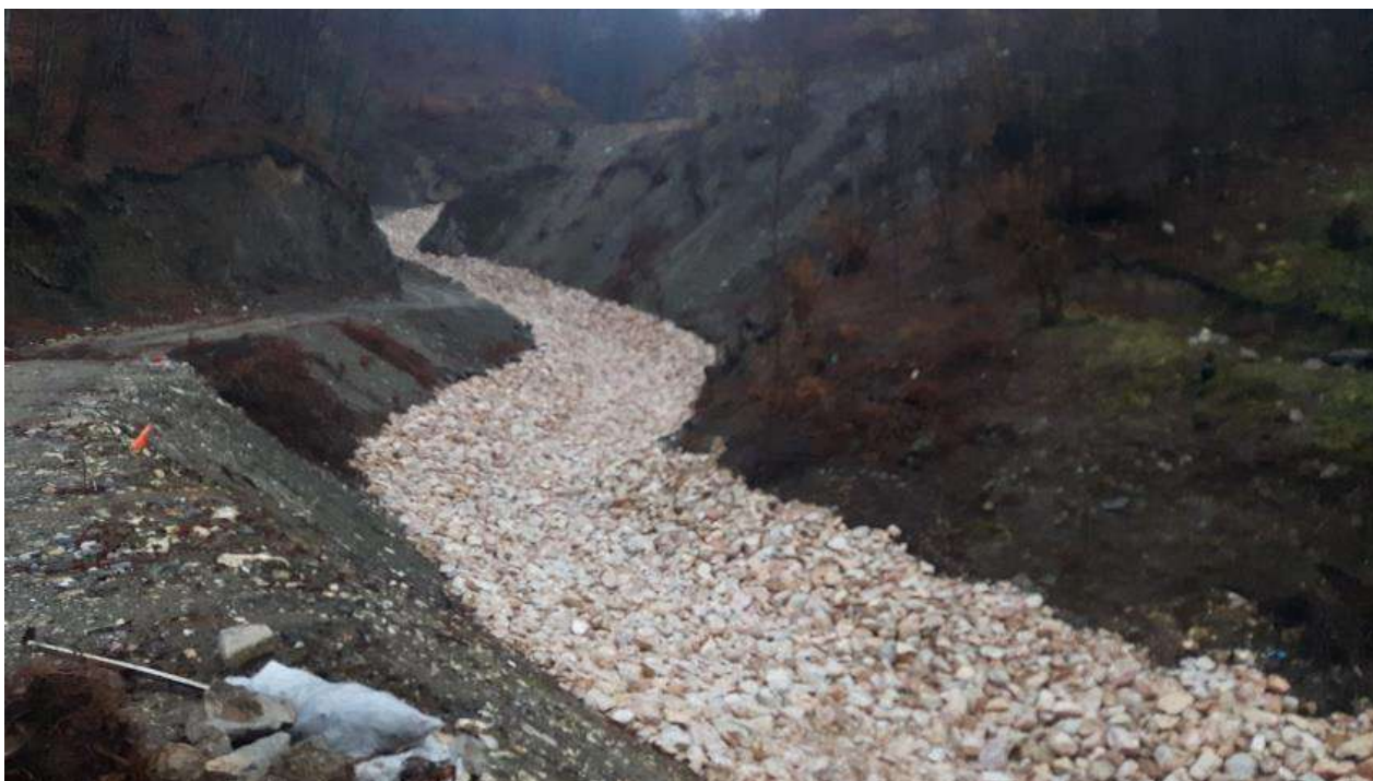
Foto 30: Masat e ndërmarra kundër erozionit nga kompania Bechtel Enca në përroin e fshatit Kukaj
