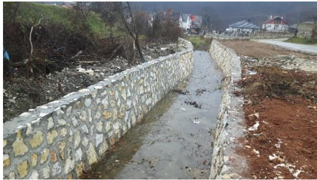
Foto 16: Rregullimi i shtratit të përroit në rrugën -“Xhevë dhe Fehmi Lladrovci”- Runjevë dhe rregullimi i shtratit të përroit në fshatin Soponicë lagja Dallosh
