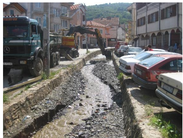
Foto 14: Pastrimi i lumit Nerodime - Runjevë 2024 Foto15 : Pastrimi i përroit Rakoc pas reshjeve
