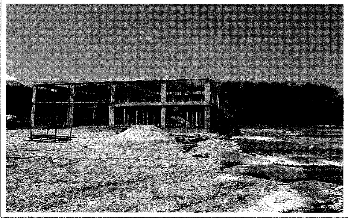
(Foto nr 2, Ndërtimi i Objektit )
