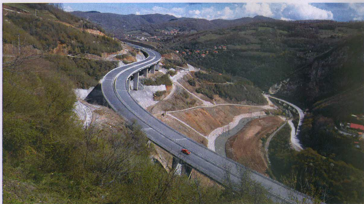
Foto: Rregullimi i shtratit të lumit Lepenc dhe ujëmbledhësve përgjatë autostradës “Arbër Xhaferi”
